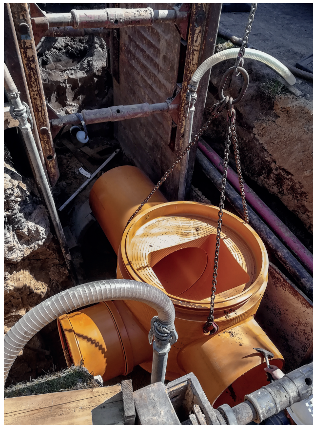
Bild 4. Präzise an die Einbauumgebung angepasst, punkten Kunststoff-Schächte gegenüber ihren Pendanten aus Steinzeug und Beton auch durch ihr geringeres Gewicht © Rehau
